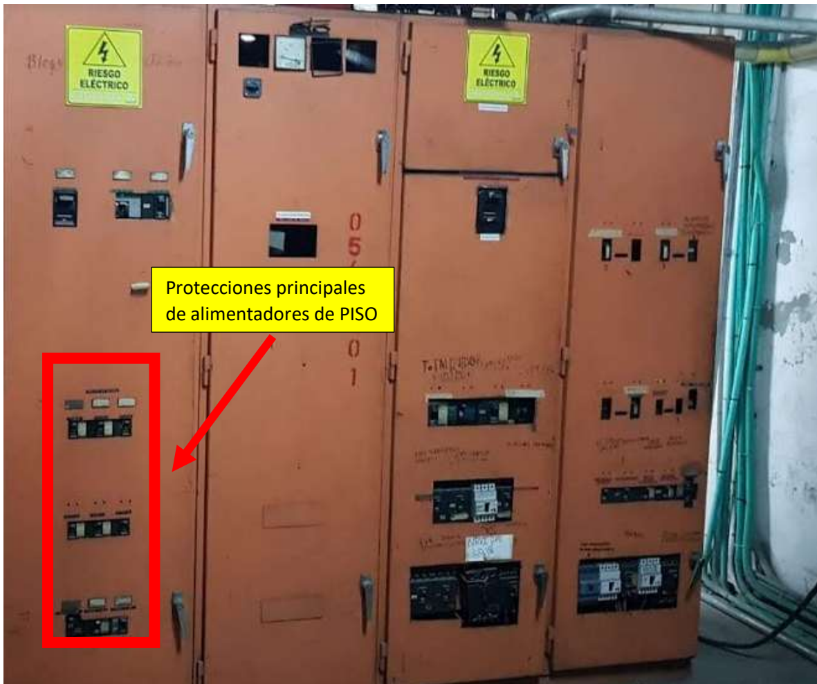
Ilustración 1. Ubicación protecciones para alimentadores de pisos
