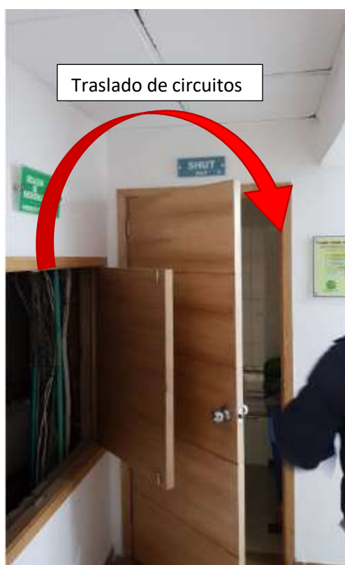
Ilustración 4. Traslado de circuitos a cuarto contiguo en armario de medidores
